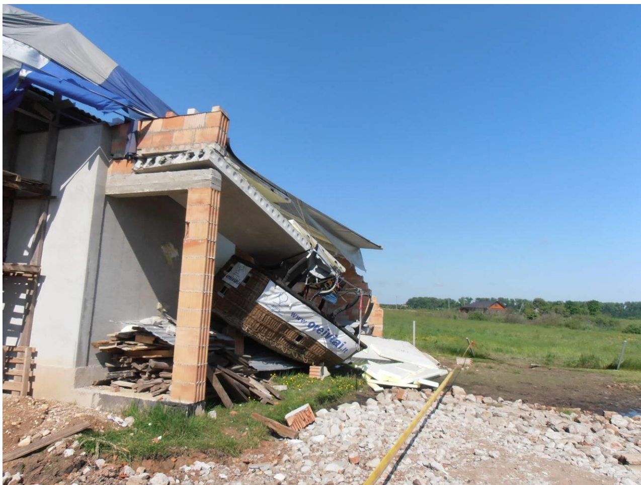
5 pav. Apgriautos namo konstrukcijos.
